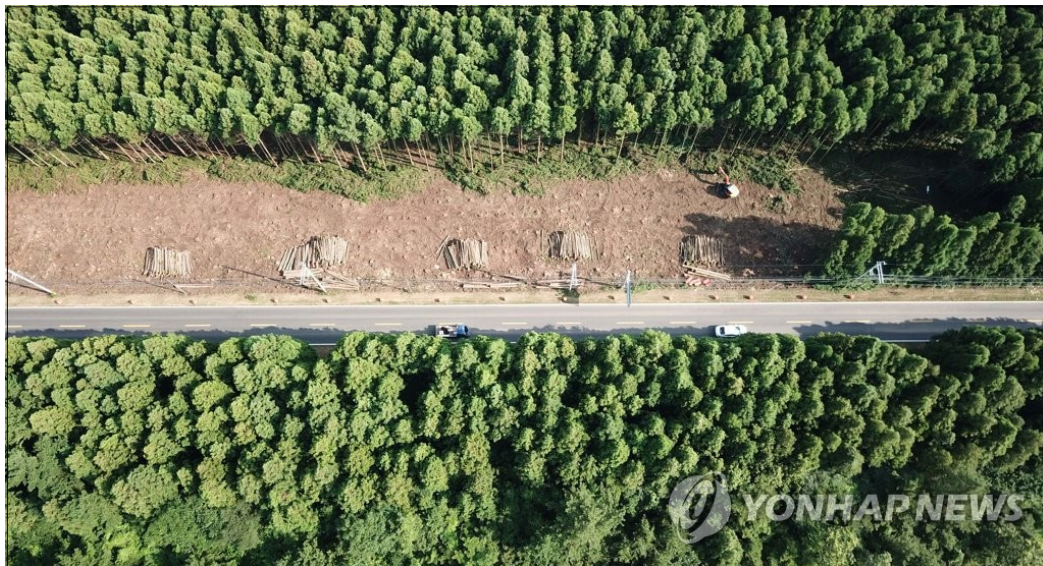
[사진-1] 제주도 비자림로 공사 현장(2018.12.9. 연합뉴스 자료사진)
